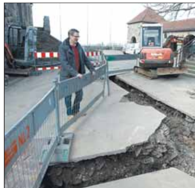
Im Burghof warten noch die Bagger: Architekt Steffen Seiferheld besichtigt „seine Baustelle“.
